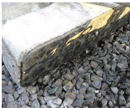
Abb. 2: Besohlung Betonschwelle nach Einsatz Quelle: Getzner Werkstoffe GmbH
